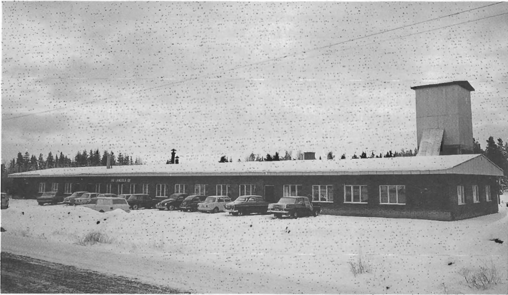
Landolan kitaratehdas rakennettiin Pietarsaaren maalaiskunnan Sandsundiin vuonna 1967. Landolas gitarrfabrik byggdes i Sandsund, Pedersöre år 1967.
