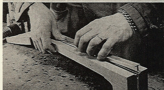
Insättning av T-balkförstärkning
